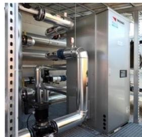
Figure 56: groupe froid à absorption (Serm)
